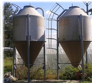
Silos à grains
