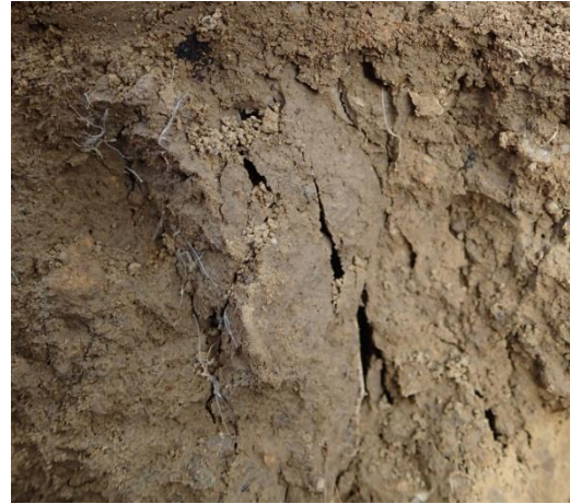
Fig. 16 Fissure + Racines - H2
