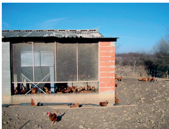
Exemple de bâtiment fixe
